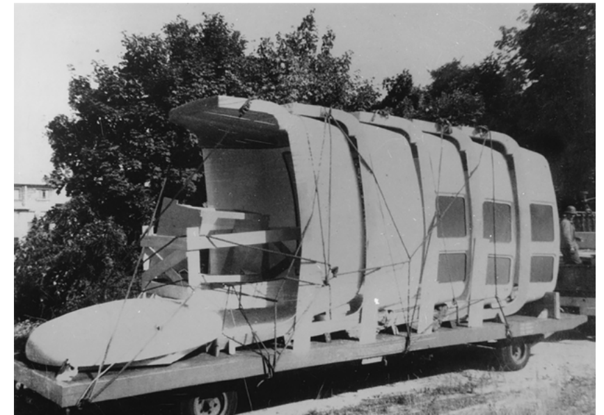
figura 1 Bulle six coques , Jean Benjamin Maneval. Diseños de elementos prefabricados y sistema de desplazamiento y montaje; conjunto de “conchas” en serie acopladas, y mobiliario, sobre camión. L'Architecture d'aujourd'hui , num.148 (1970); Archivos Familia Maneval, “Prototipo de seis casos burbuja Jean Benjamin Maneval”, www.bubblemania.fr
