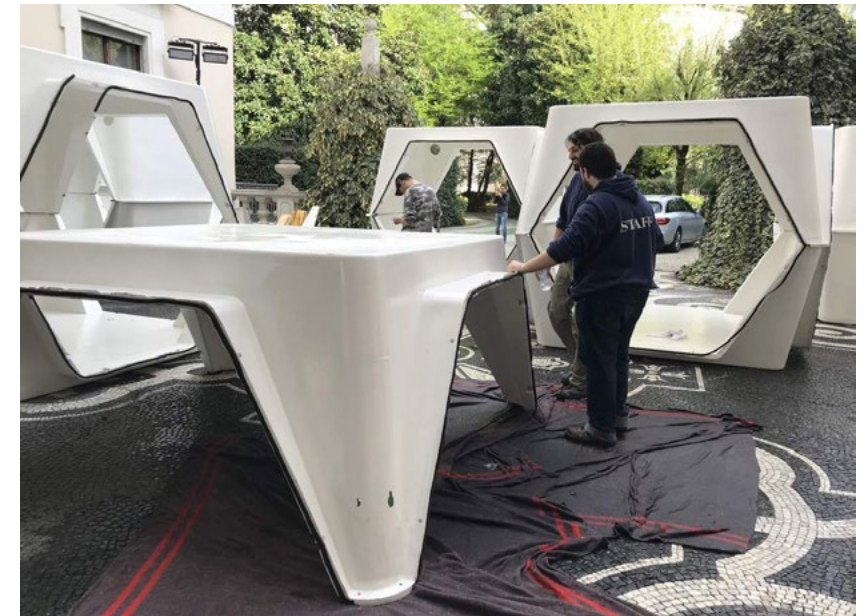
figura 14 y 15 Hexacube . Reconstrucción de la célula por Clément Cividino: proceso de desplazamiento, colocación de elementos y montaje, y “vivienda evolutiva” tipo, combinación células. Exposición realizada en Milán 2018: Instalación Louis Vuitton. “Hexacube - Georges Candilis” Clément Cividino. www.clementcividino.over-blog.com
