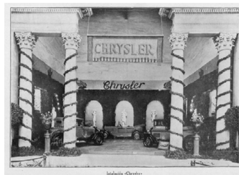
figura 4 Instalación Chrysler en el V Salón de Barcelona. Madrid automóvil : Madrid, junio de 1927, nº 30, pp. 2.
