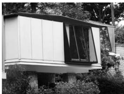
[foto 3] Pórtico central de chapa de acero.
