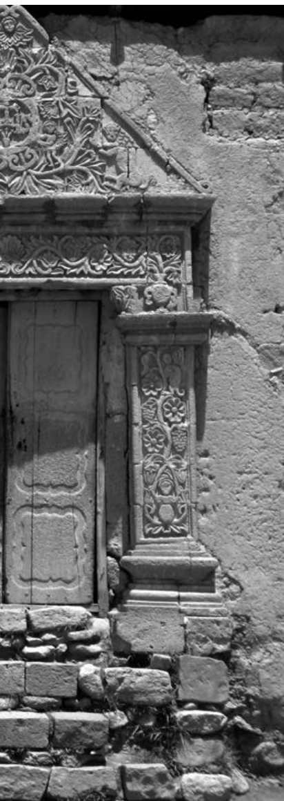
Restos de arquitectura colonial en Juli, Perú.
