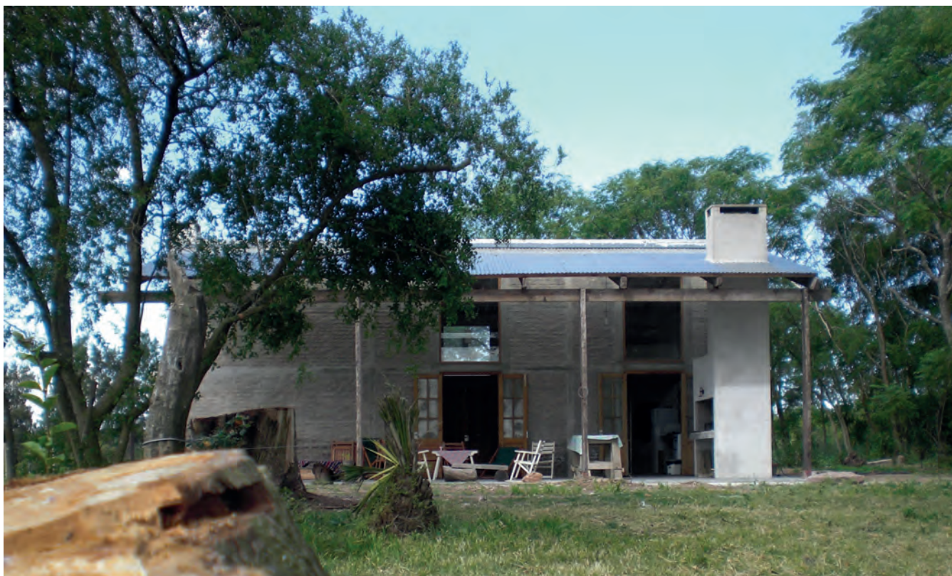
Transformación de la antigua bodega en un espacio flexible destinado a convertirse en un refugio y un lugar de encuentro. El edificio existente brinda las pistas necesarias sobre la materialidad y el carácter de la nueva intervención.
