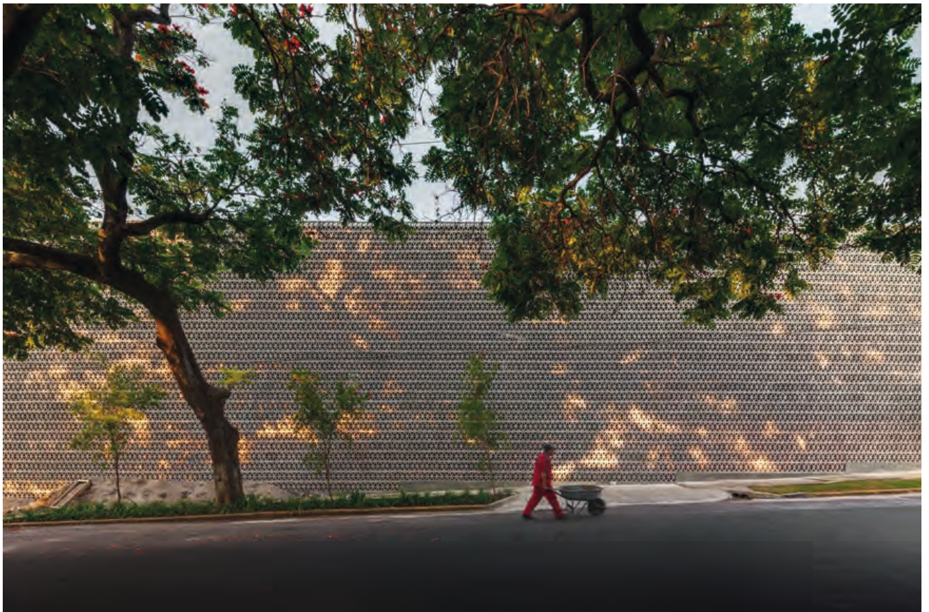
Celosía desarrollada a partir de una pieza especial de hormigón prefabricado producida a medida. Basada en el modelo industrial.
