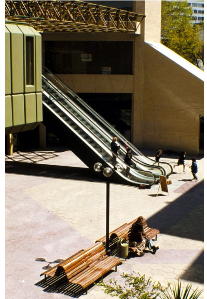
figura 23 Estereométrica y escalera mecánica urbana –las primeras en Santiago de Chile- desde el puente sobre Paseo Las Palmas. Fotografía inédita 1977, archivo personal Pedro Murtinho
