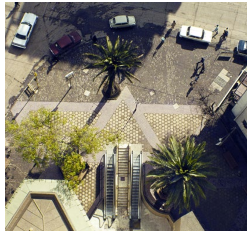
figura 22 Plaza tridimensional subterránea, 'POPS' en esquina Nor-Poniente de edificio Centro Nuevo, acceso al sistema de galerías y Metro, y, calle Las Palmas convertida en paseo peatonal. Fotografía y dibujo inédito, archivo personal Pedro Murtinho
