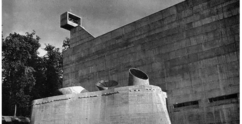
figura 3 Muro norte de la Iglesia del Monasterio de La Tourette. Le Corbusier. 1960. Fuente: C. Rowe. Architectural Review (June 1961): 404
