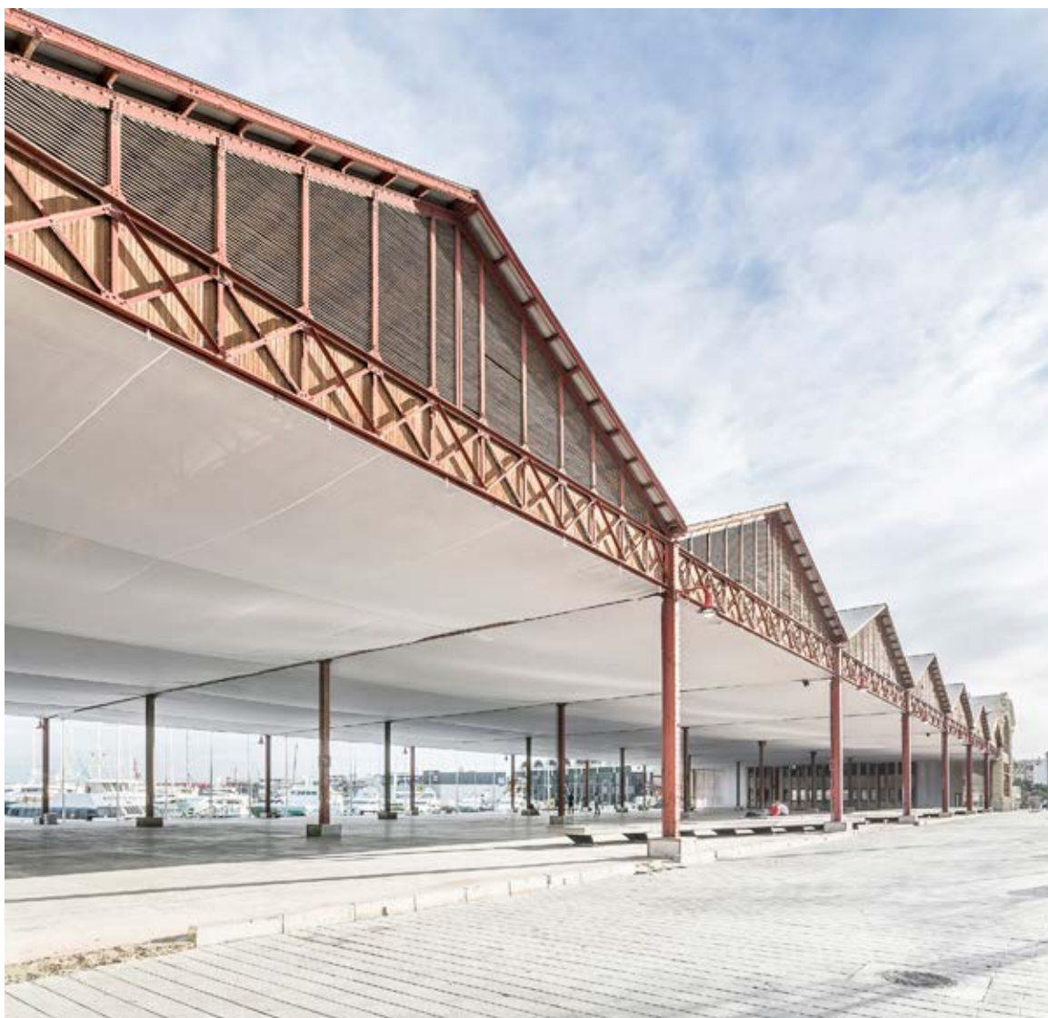
figura 1 Tinglado 2 RELLAM (Imagen cortesía de RELLAM)
