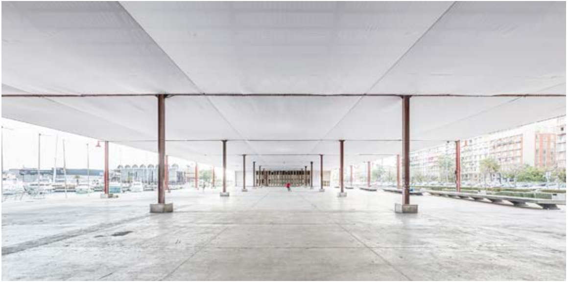
figura 3 Tinglado 2 RELLAM (Imagen cortesía de RELLAM)
