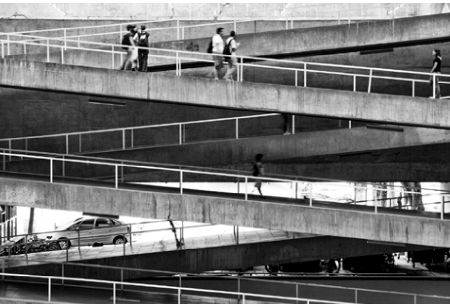
figura 1 Detalle del haz de rampas en la Facultad de Arquitectura y Urbanismo de la USP, de João Vilanova Artigas (São Paulo, 1961-1968). Fotografía de Nelson Kon
