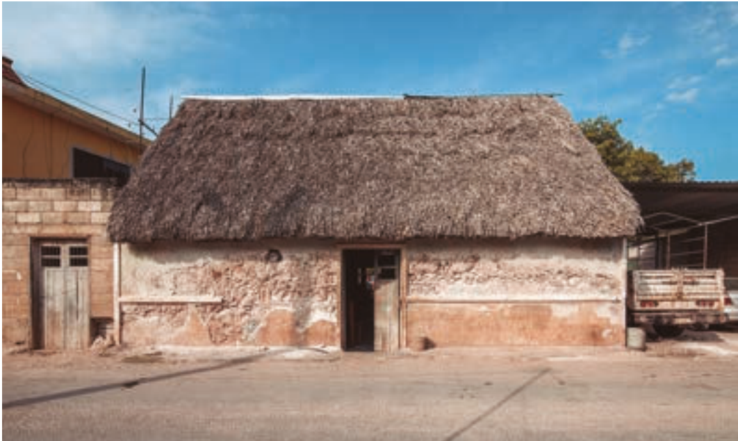
Tipologías. Estado actual de la vivienda tradicional en México. Dzitbalchén, Campeche, México. Fotografía: Onnis Luque
