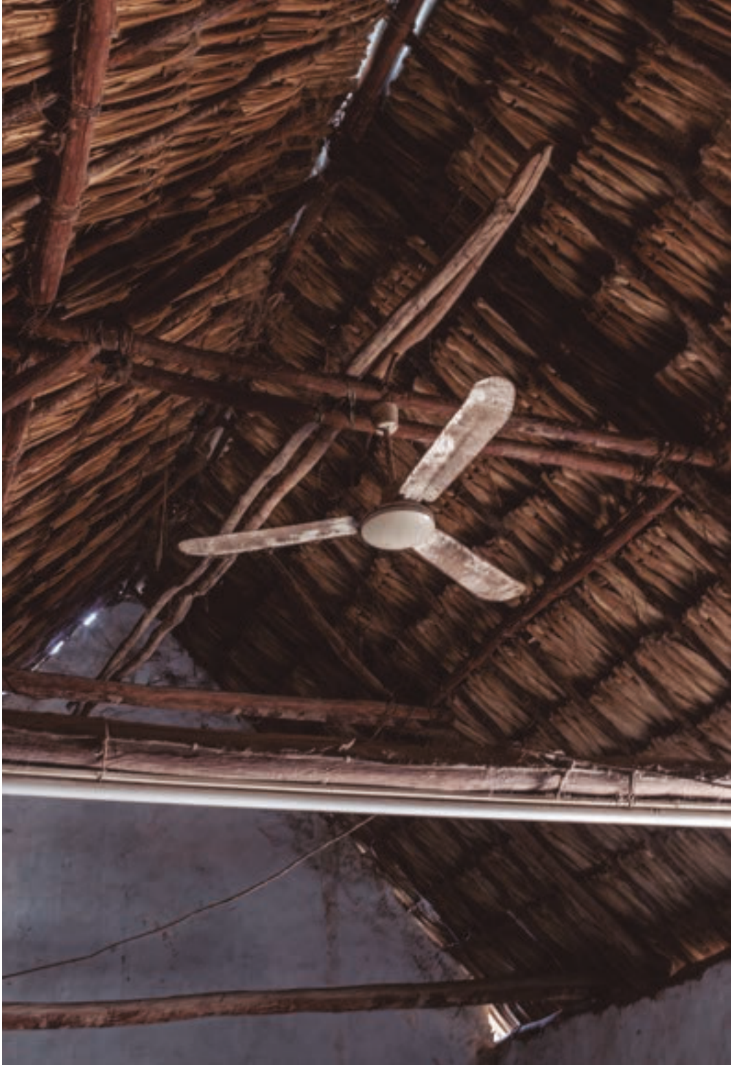
Tipologías. Estado actual de la vivienda tradicional en México. Caprizo, Campeche, México. Fotografía: Omnis Luque
