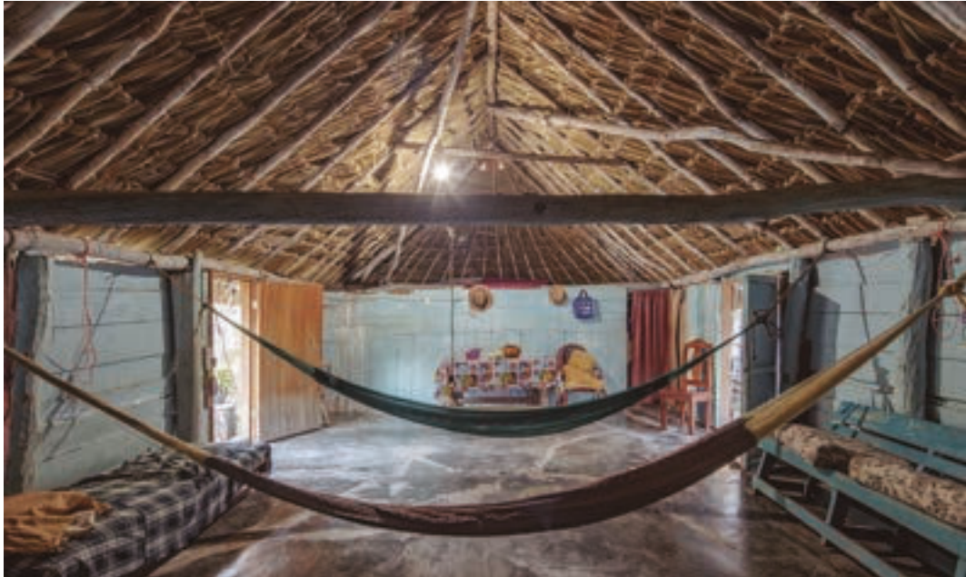
Tipologías. Estado actual de la vivienda tradicional en México. Zoh Laguna, Campeche, México. Fotografía: Onnis Luque
