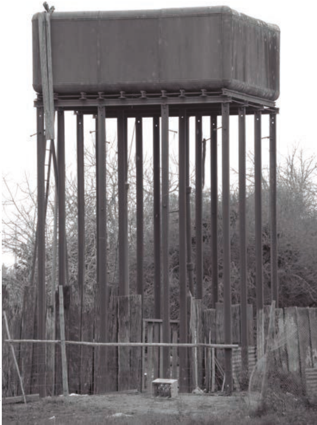
Torre de agua de hierro y rieles de tren. Alcones, Marchigüe, VI Región, Chile. Fotografía: Camilo Palma
