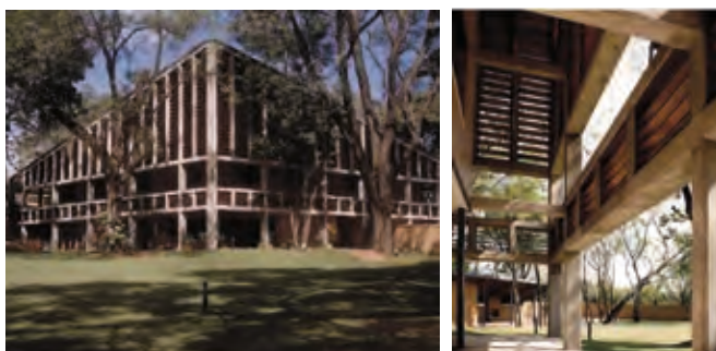
Construcción de la embajada de España, Asunción, Paraguay, 2000
