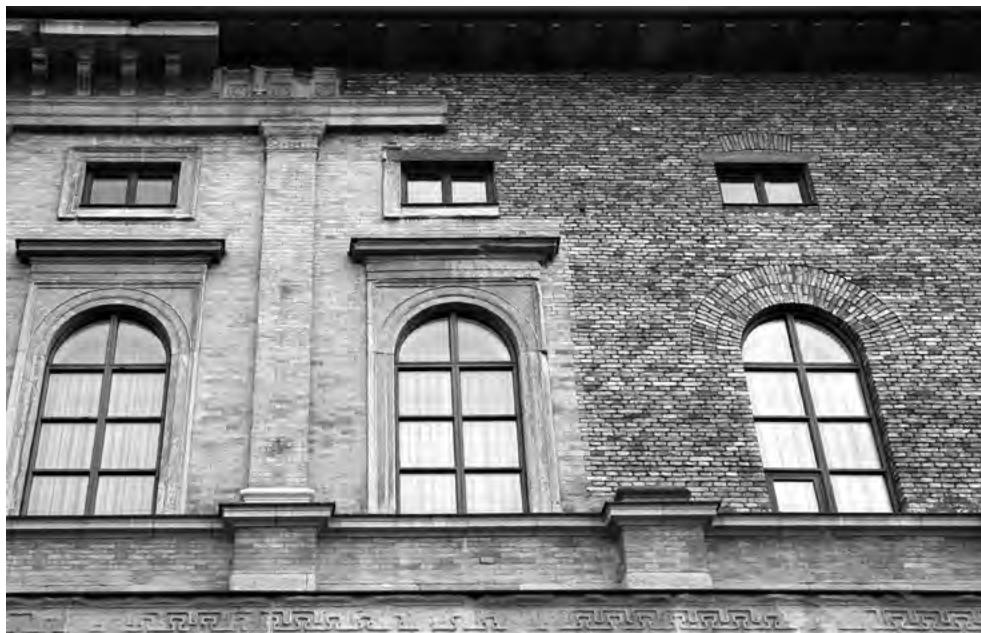
[6] Detalle de la consolidación de los restos de la envolvente de Klenze por Döllgast completando sillares dañados con fábrica de ladrillo y adosado de otros restos de la fábrica antigua a la nueva fábrica de Döllgast. Autor: Elena Zapatero Rodríguez.
