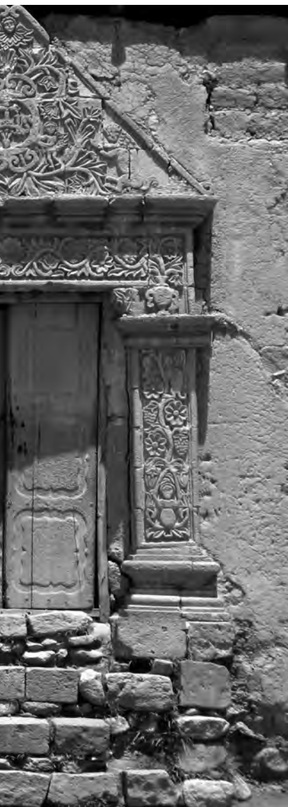
Restos de arquitectura colonial en Juli, Perú.
