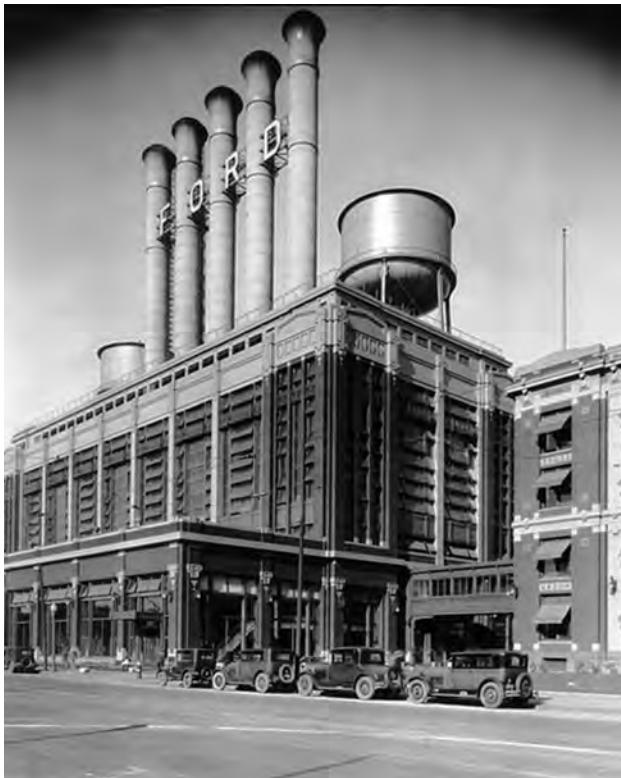
[2] Albert Kahn Inc. Edificio de generadores de Highland park Old Shop. Detroit News archives photos.
