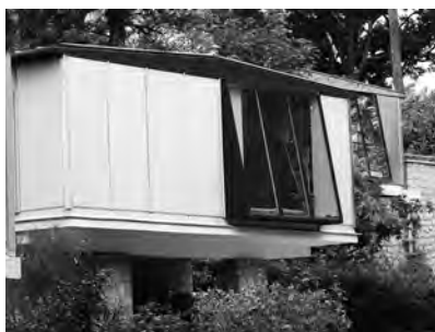
[foto 3] Pórtico central de chapa de acero.
