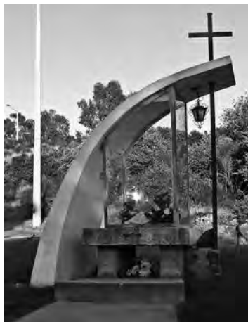
[3] El deseo de moderno y la reivindicación de las raíces, presentes en la búsqueda arquitectónica que ocupaba a los arquitectos de la generación de los cincuenta en Portugal (imagen: Camarin en la entrada de Picote). Fotografía: Javier Encinas.
