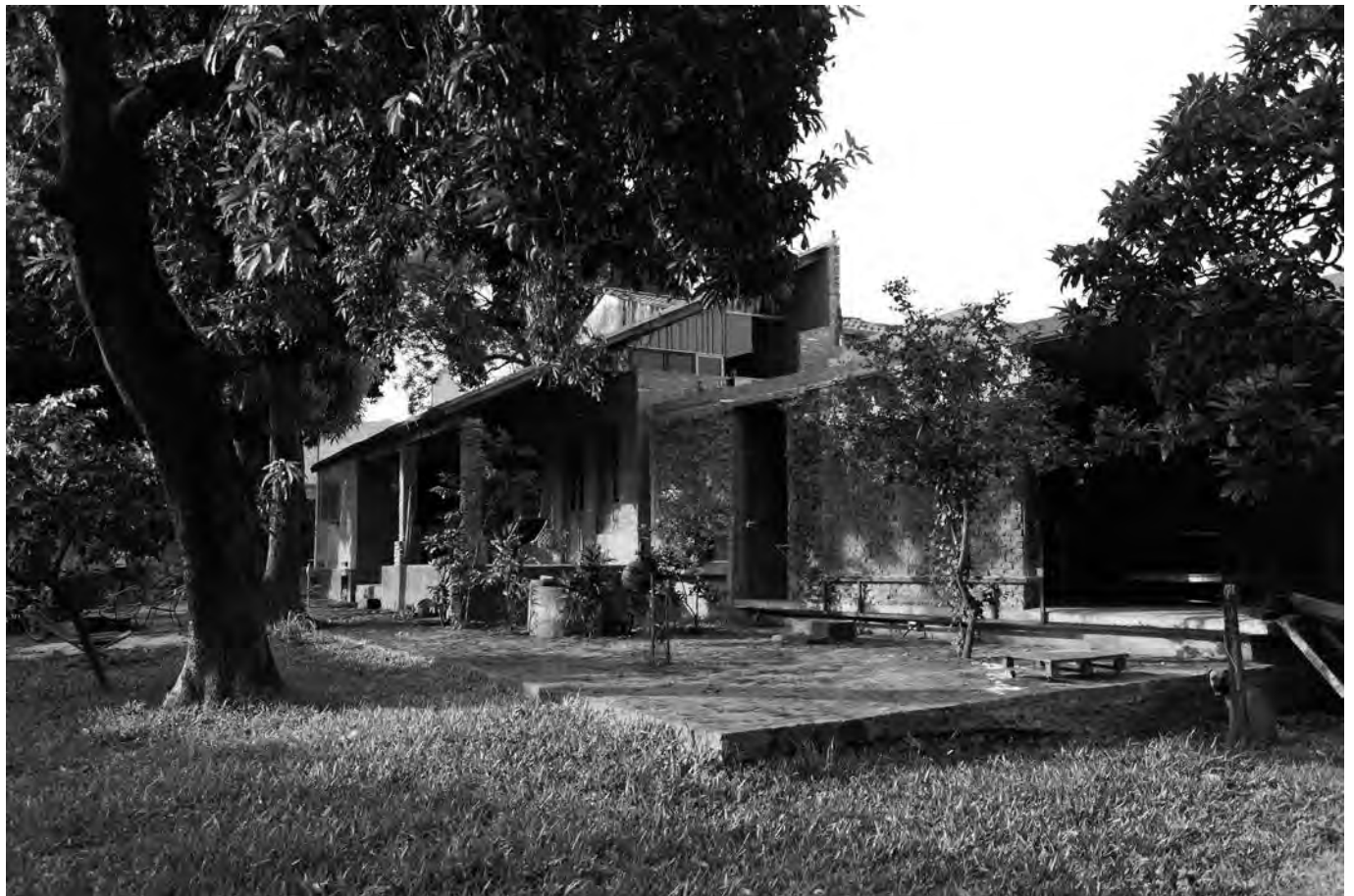
Arriba, espacio principal de la rehabilitación en doble altura. Abajo, vivienda rehabilitada desde la extensión del taller a partir de ladrillo recuperado. Derecha, acceso al taller.
