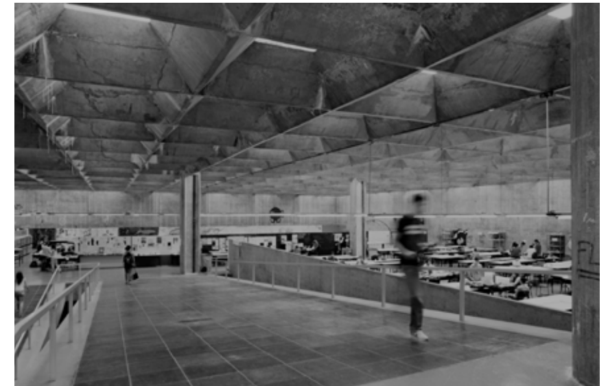
figura 20 La monumental cubierta reticular de la Facultad de Arquitectura y Urbanismo de la USP es sin duda el elemento más representativo de la arquitectura paulista. La concepción espacial abierta del atrio y los talleres responde al nuevo programa de estudios trazado por el propio Artigas a principios de la década de 1960.
