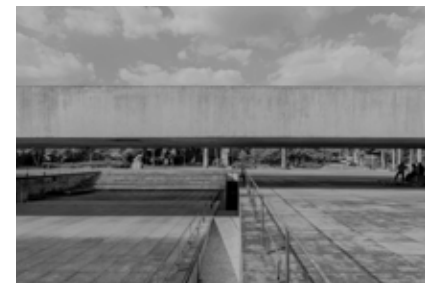
figura 3 Dimensión Comunicativa Arquitectura El Museo Brasileiro da Escultura (MuBE), magnum opus del arquitecto Paulo Mendes da Rocha (São Paulo, 1987), con su marquesina de 70m de vano libre, acota el fondo urbano de manera apaisada. Procedencia de la imagen: Divisare. Fotografía de Leonardo Finnotti, 2018
