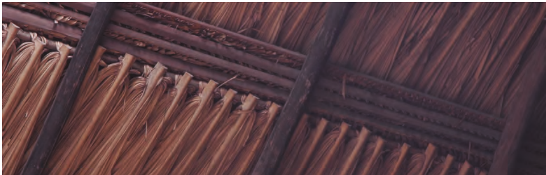
Estructura de cubierta en madera. Reserva Natural El Matuv, corregimiento de Palomino, La Guajira, Colombia. Fotografía: Martín Olga Valderrama - AGRA
