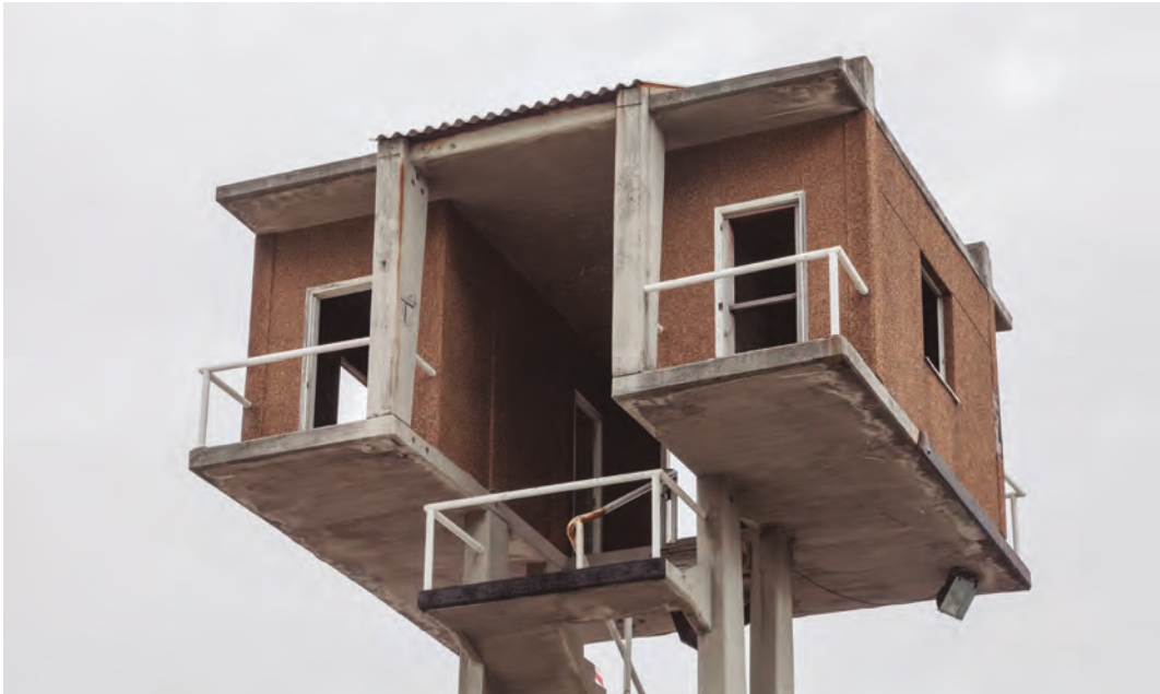
Arquitectura y resistencia. Autoconstrucción. A Coruña, España. Fotografía: Nicolás Combarro
