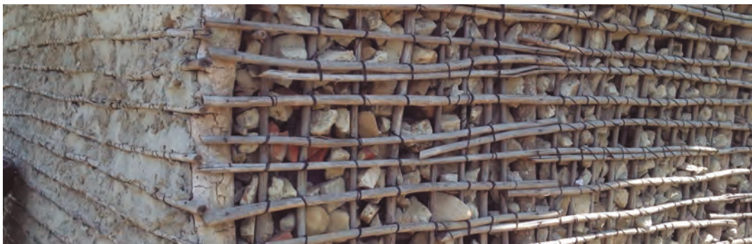
Cerramiento de doble enmallado en Lata de Corozo. San Juan Nepomuceno, Bolívar, Colombia. Fotografía: María Inés García-Reyes - AGRA
