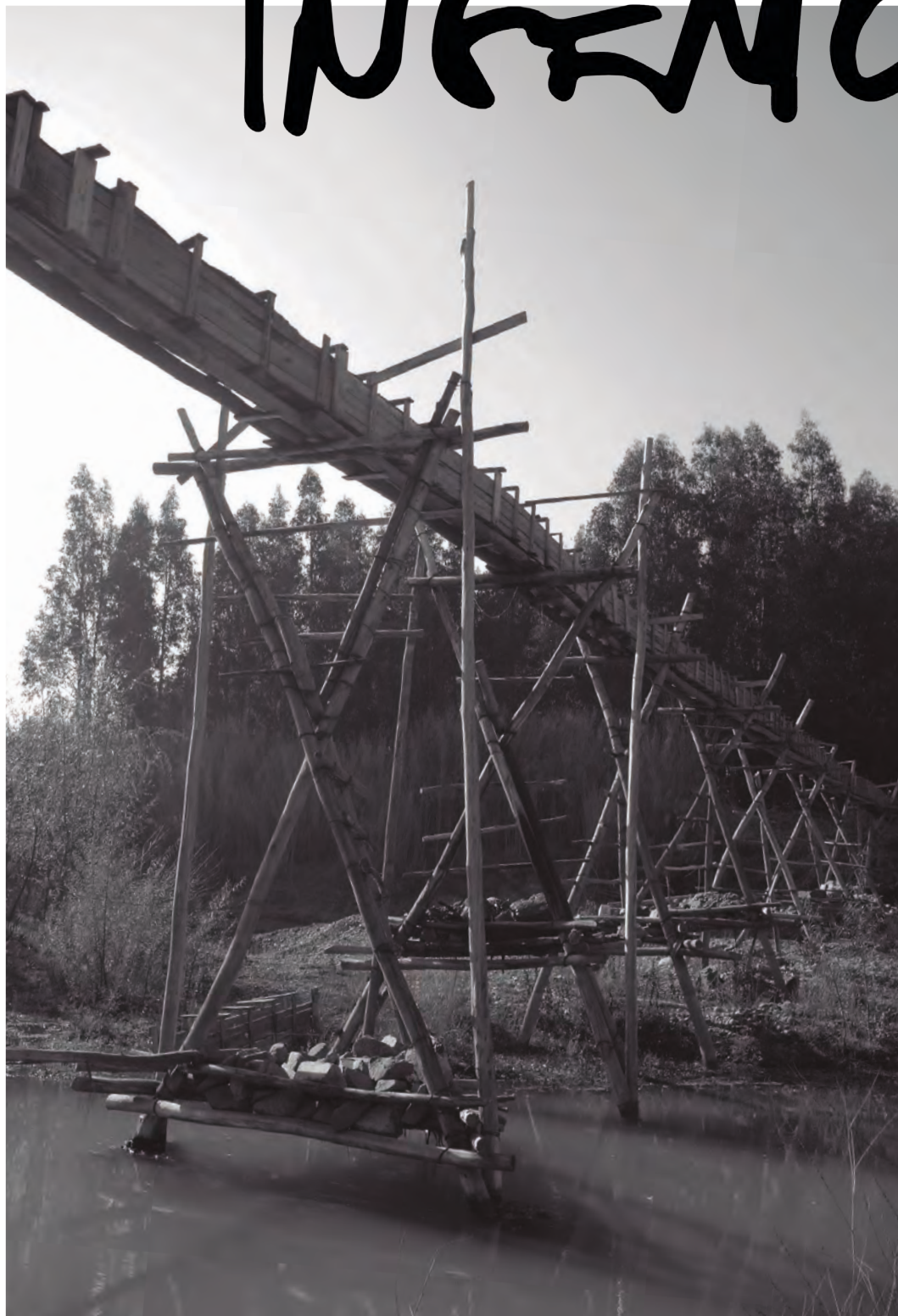
Acueducto rural sobre el río Tinguiririca. Apatla, VI Región, Chile. Fotografía: Camilo Palma
